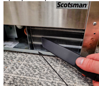
Surface du condenseur
